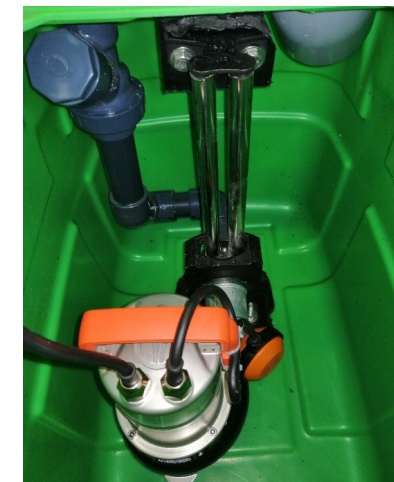
sustav za automatsko spajanje pumpe na tlačni vod s INOX AISI 304 vodilicama i lancem
